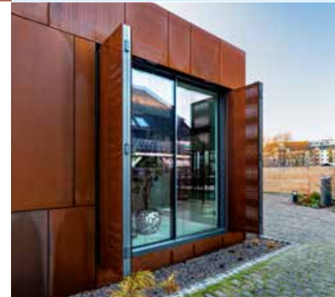
Schiebefallläden aus Cortenstahl. Denkmalgerechte Sonnenschutzlamelle.
